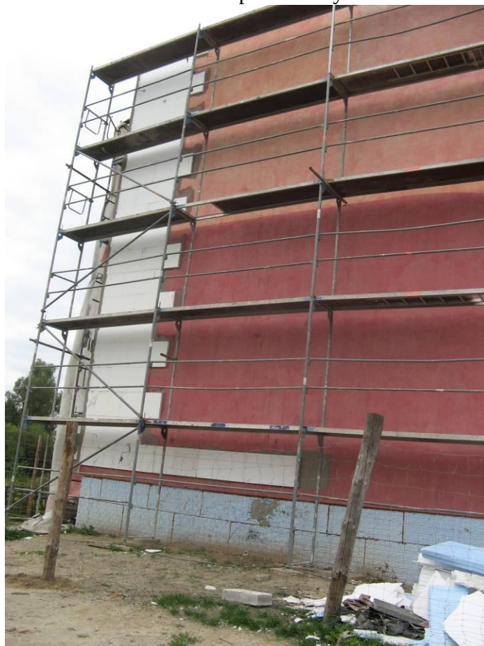
Fot. 1 . Docieplanie budynku
