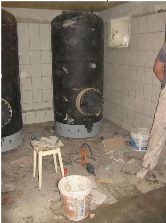
Fot. 3. Remont węzła
