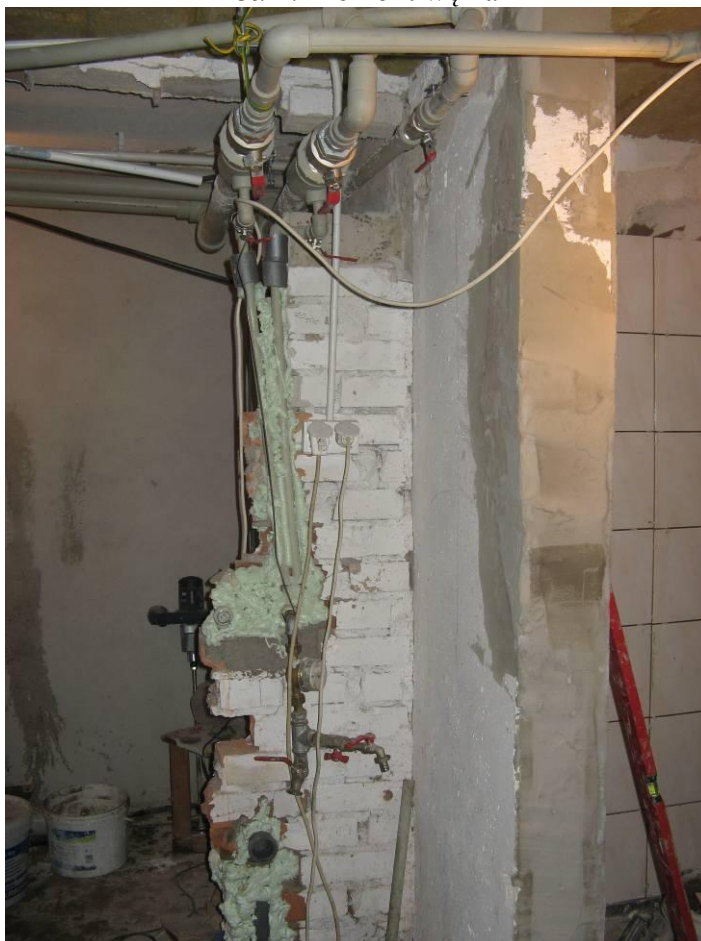
Fot. 4. Remont węzła
