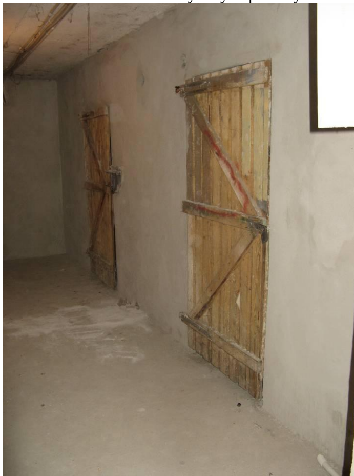
Fot. 5. Remont korytarzy w piwnicy
